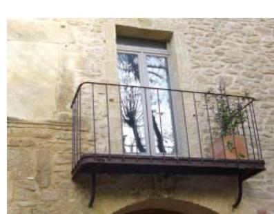
Balcon sur consoles métalliques et garde-corps de ferronnerie
