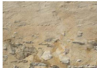
*Enduit à "joints beurrés", à prendre en exemple*
