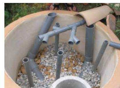
*Des drains de fond (Ø : 100 mm) reliés à la surface par des tubes PVC et des tubes verticaux d'aération percés (Ø : 50 mm), sont insérés au moment où l'on place la couche de galets de fond.*
