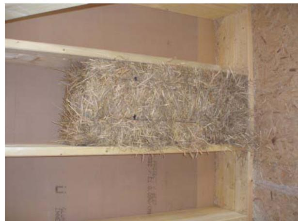
*Remplissage d'une ossature bois par des bouteilles de paille*
