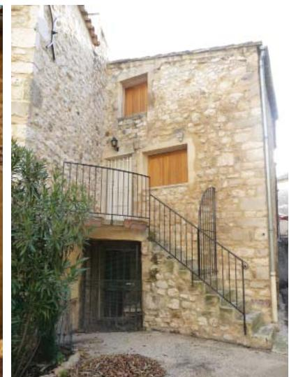
*Bon exemple de rambarde mais sol réalisé en carreaux de terre cuite, de facture industrielle, se "mariant" mal avec l'aspect naturel de la pierre.*
