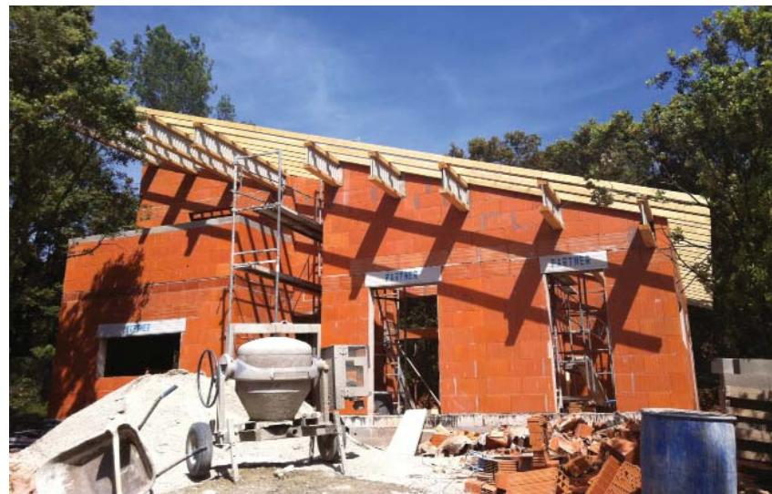
*Maison Cabrol à Saint-Gély-du-Fesc (Hérault), lauréate du concours BBC catégorie "Construction BEPOS". Murs extérieurs en briques à joint mince de 20 cm + un isolant naturel (mélange de chanvre et fibre de bois) de 100 mm à l'intérieur
