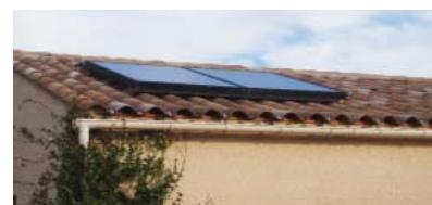
*Capteurs en surimposition de toiture (4 m<sup>2</sup> environ de surface de capteurs solaires thermiques pour 200 à 300l d'eau chaude)*
