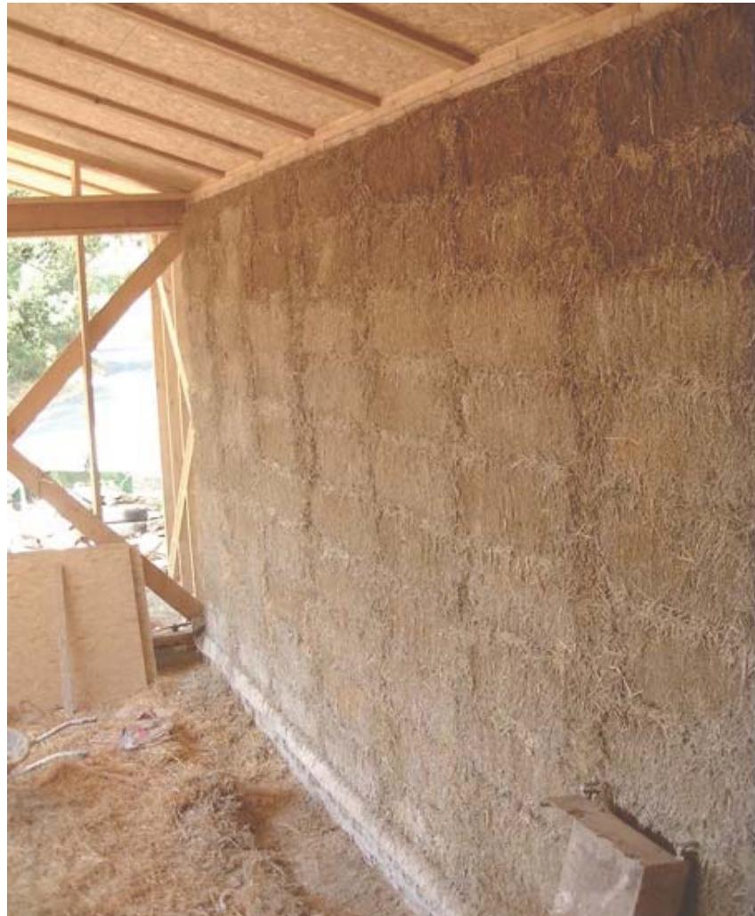
*Mur en bouteilles de paille avant enduit*
