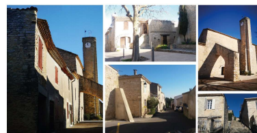
Patrimoine bâti du vieux village Source : Verdi, 2022
